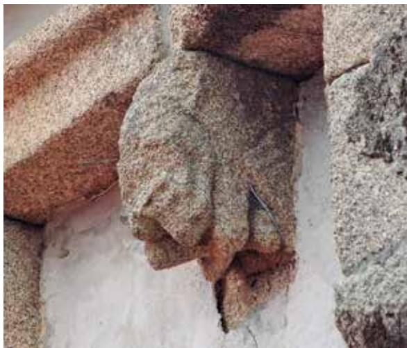
Ilustración 38. Canecillo muro sur. Cancerbero.
