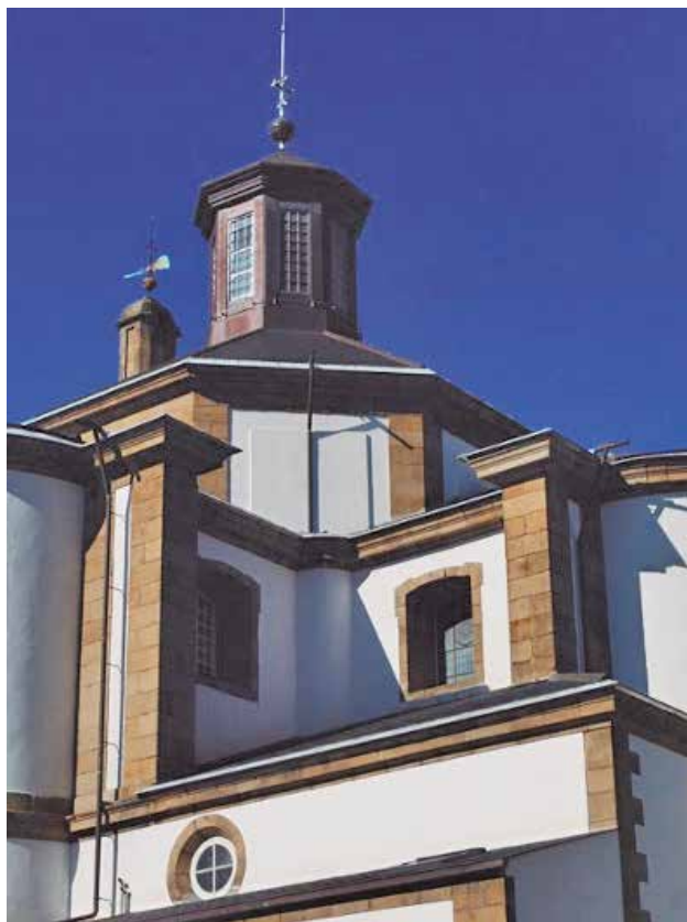
Linterna. La original tenía columnas y estaba forrada en plomo o en cobre. El resto de los tejados eran en teja. Foto de Kiko Delgado.
