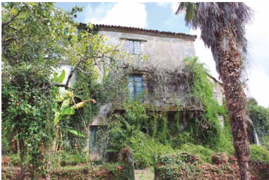
Fig. 6. Torre de Raíndo. 1700. Fotografía do autor.
