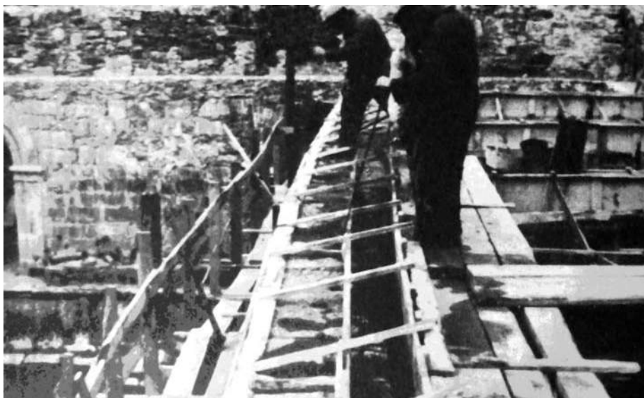
Fotog. 11. Obras de atirantado no claustro procesional. Decembro de 1970, durante a intervención de Francisco Pons Sorolla. Fonte: G. López Collado, Ruinas en construcións antigas. Causas, consolidacións e traslados (Madrid 1976) 276.
