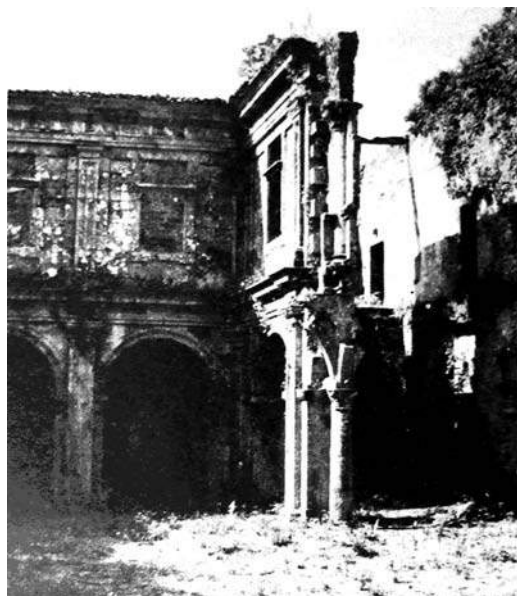
Fotog. 7. Detalle do claustro da hospedaría. Imaxe tomada en xullo de 1962, antes da intervención de Francisco Pons Sorolla; onde poden observarse restos da estrutura renacentista anterior. Fonte: G. López Collado, Ruinas en construcións antigas. Causas, consolidacións e traslados (Madrid 1976) 436.
