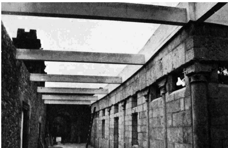
Fotog. 12. Obras de atirantado no claustro procesional. Xullo de 1971, durante a intervención de Francisco Pons Sorolla.
