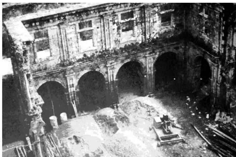
Fotog. 8. Fase de obra: Claustro da hospedaría. Xullo de 1970, durante a intervención de Francisco Pons Sorolla. Fonte: G. López Collado, Ruinas en construcións antigas. Causas, consolidacións e traslados (Madrid 1976) 436.
