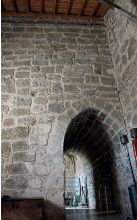
Figura 2. Base de la torre y albarrana.
