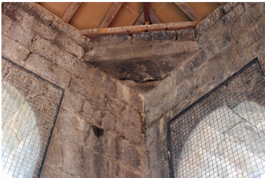
Figura 7. Encuentro poligonal del remate de la torre que pudo servir de base al chapitel.
