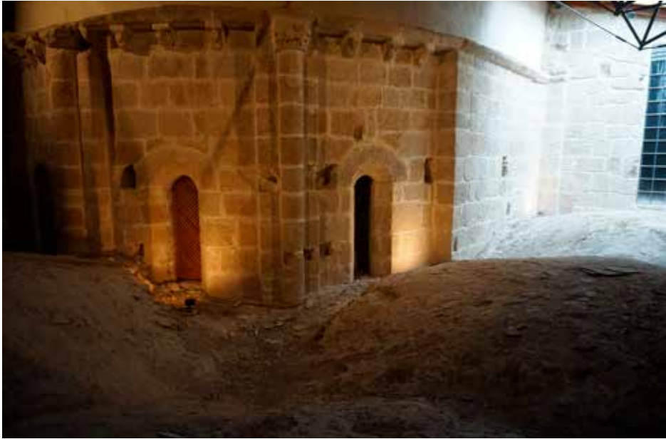
Fig. 16. Huellas de los mechinales en el ábside medieval que sirvieron de apoyo para las vigas de la cubierta del deambulatorio (Fondo JRLC).
