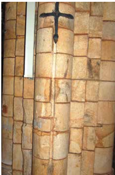
Fig. 5. San Martiño de Mondoñedo (Foz), interior, primeiro machón meridional, nave central, fenda para a encaixe do cancelo ou panel de separación entre o transepto (coro de cóengos) e as naves (pobo).
