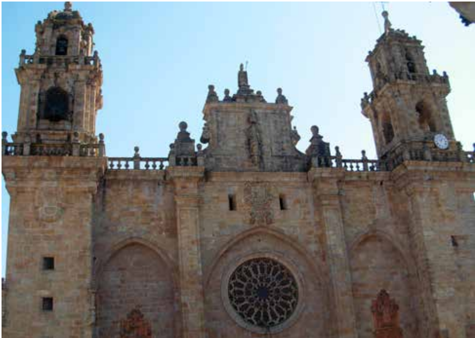
Fig. 2. Fachada barroca de la catedral de Mondoñedo en la que fueron reaprovechados la portada y el rosetón medievales.
