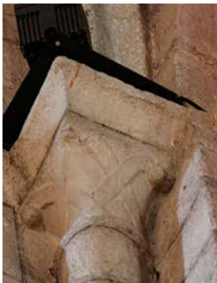
Fig. 17. Capitel da Catedral de Mondoñedo con cintas entrelazadas, tipo cisterciense. Pedra granítica.
