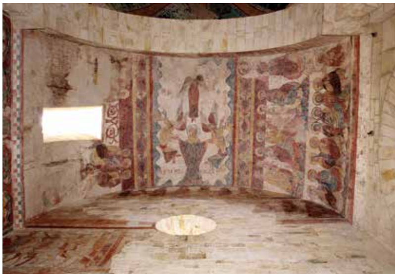
Fig. 6. San Martiño de Mondoñedo (Foz), muro meridional, bóveda pintada do brazo sur do cruceiro: pinturas murais.
