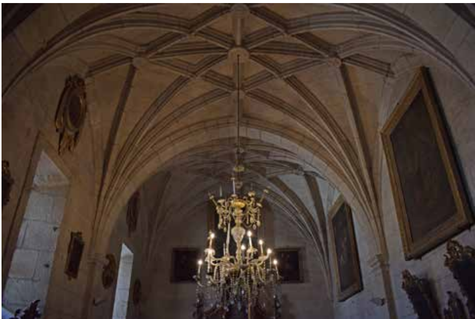
Fig. 4. Bóvedas de la sacristía capitular.
