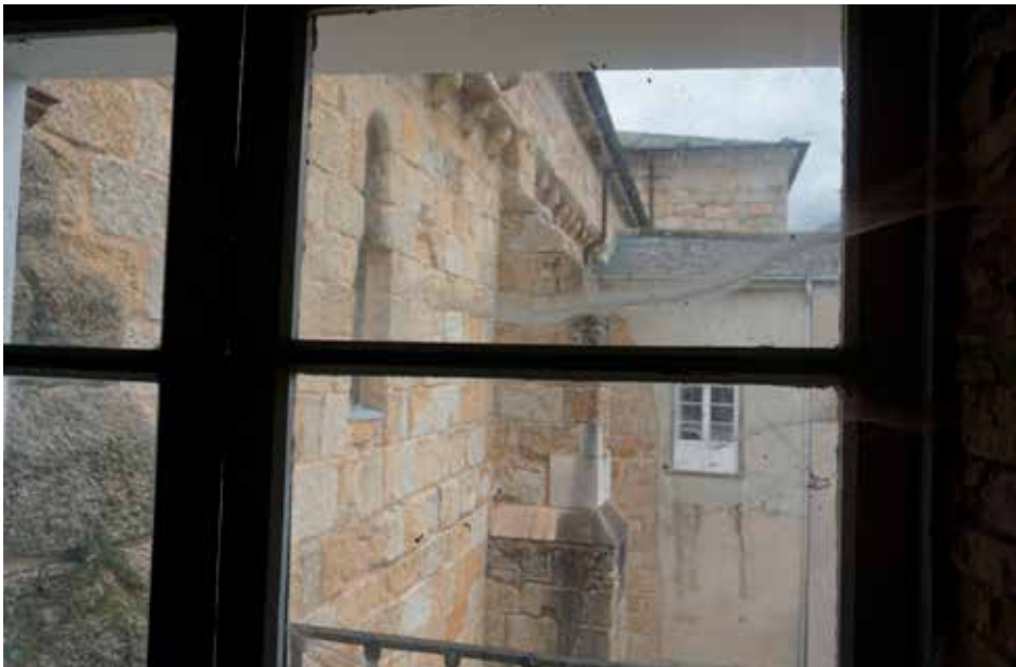
Fig. 15. Detalle de la cornisa con sus canecillos medievales que se conserva en el muro exterior de la nave de la Epístola y que marca la altura original que tuvo el edificio en el siglo XII-XIV (Fondo JRLC).
