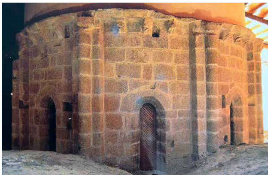
Fig. 18. Exterior de la parte alta de la capilla mayor, bajo la cubierta. (Archivo Yzquierdo).
