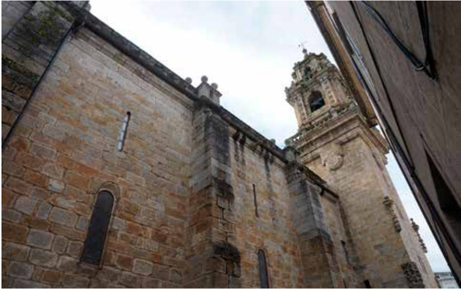
Fig. 1. Muro norte de la catedral de Mondoñedo. Paramentos y contrafuertes del siglo XIII que fueron recreados en tiempos del obispo Muñoz Salcedo (1720), cuando se construyó la fachada y la balaustra que remata los muros (Fondo JRLC).
