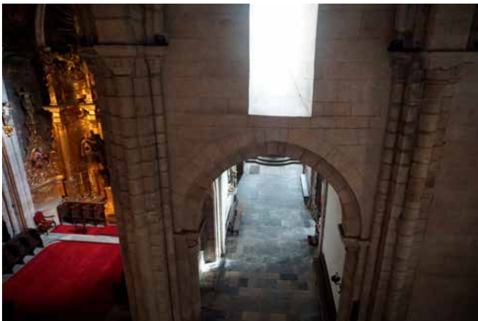
Fig. 5. Vista del crucero desde la tribuna construida por el obispo Luján (1570-1572) y reformada por el obispo Losada y Quiroga (1762-1779). Se aprecian la ventana abierta en el crucero para paliar los problemas de iluminación y el arco triunfal del ábside medieval que da acceso al deambulatorio (Fondo JRLC).
