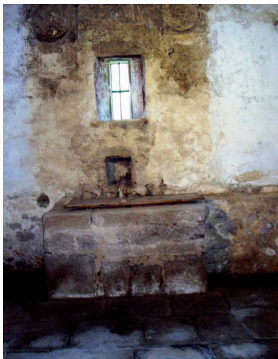
Figura 4. Muro de la cabecera con el primitivo altar.
