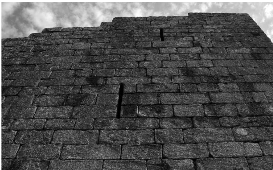
Torre homenaje oeste
