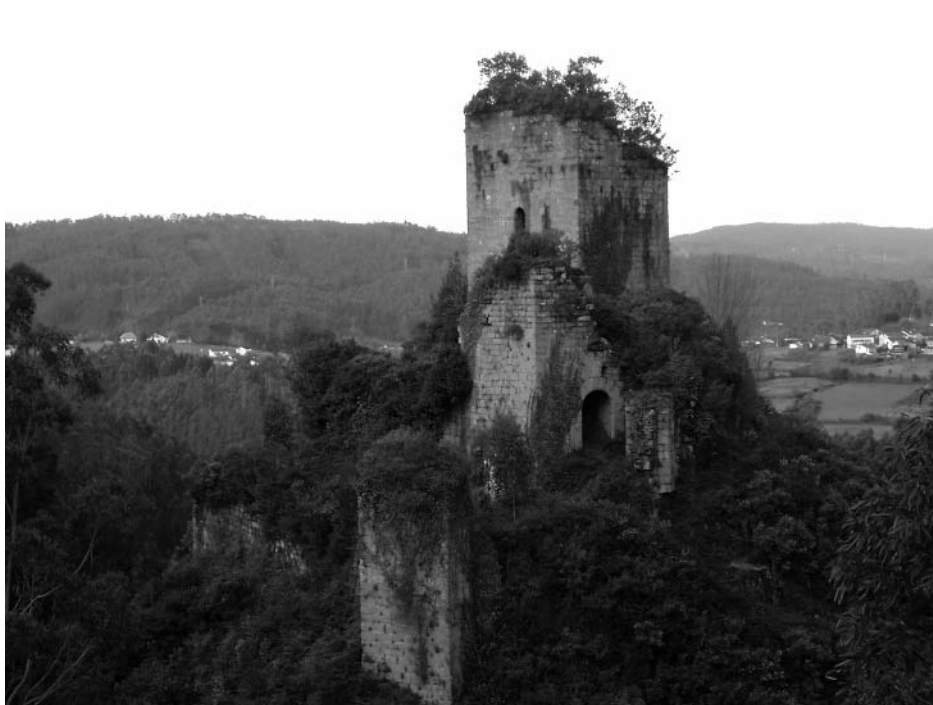
Inicio de trabajos
