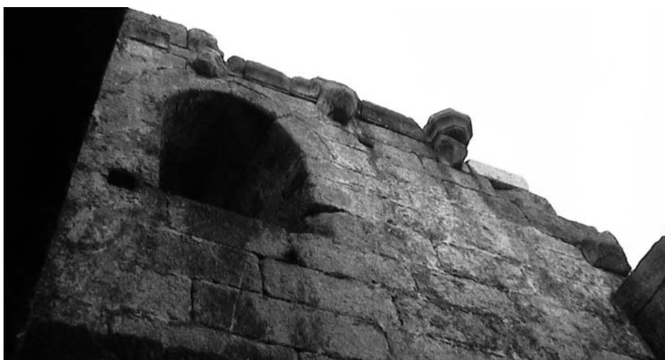
Canzorros. Interior torre
