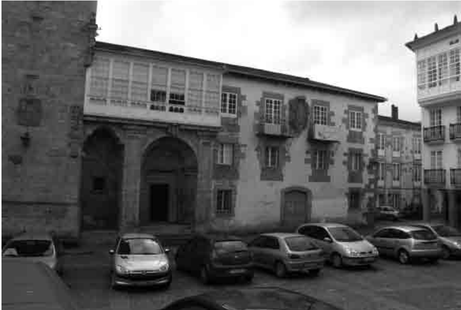
Figura 5. Fachada del palacio episcopal.
