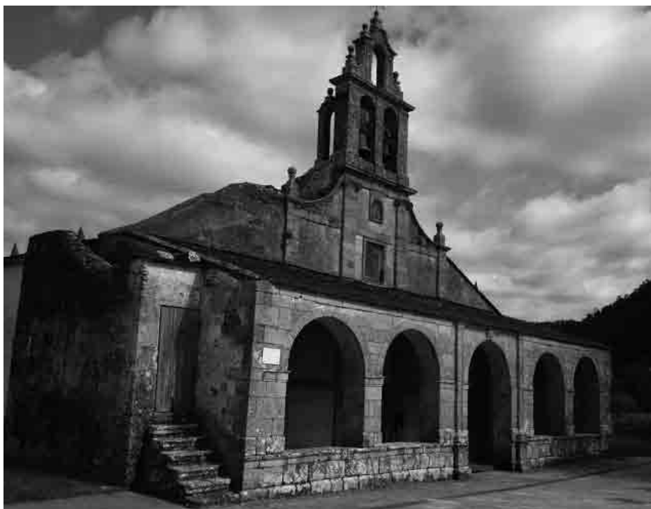
Figura 3. Fachada principal, pórtico, subida a la espadaña.
